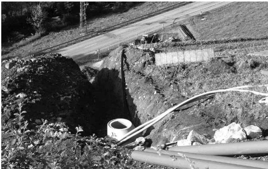
Mittel- und Niederspannungsstromleitungen vorgesehen. Im Zuge dieser Arbeiten wurden auch die Schmutz- und Regenwasserleitungen im Bereich der „Alten Schule“ Außermühlwald erneuert und vom Oberstock bis Bachlechn neu verlegt.
