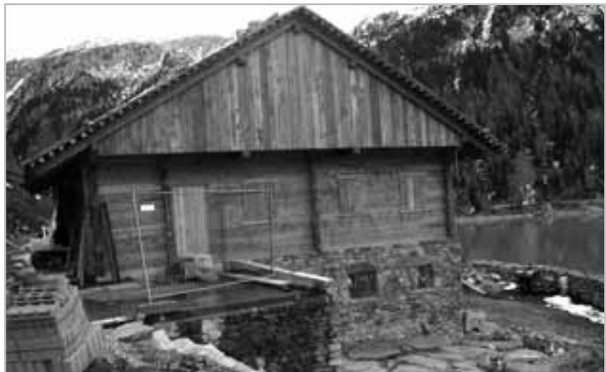
Die Verwendung von möglichst vor Ort vorfindbaren Materialien (Naturstein für das Untergeschoss) und Lärchenholz für den Oberbau war eine große Herausforderung bei der Bauausführung.
